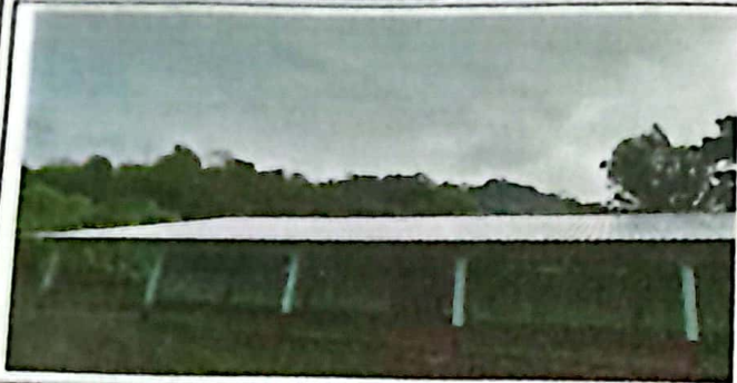
Foto 1: Imagen, que muestra 2 aulas ya entechado.
