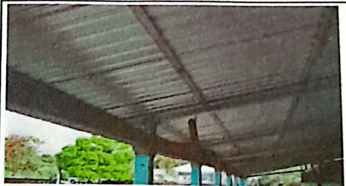
Foto 4: Imagen que muestra el corredor ya cubierta de lámina.
