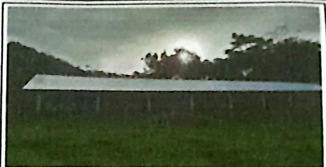
Imagen que muestra las 3 aulas ya finalizado en entechado.
